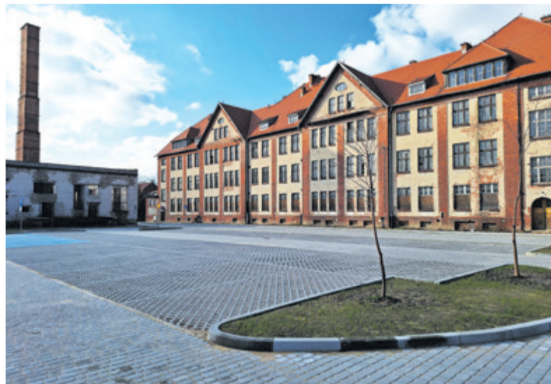
Po lewej – miejsce dawnej kotłowni, w którym powstanie Chełmińskie Centrum Usług Społecznych, po prawej – koszarowiec, który przez Chełmińską Społeczną Inicjatywę Mieszkaniową zaadaptowany zostanie na mieszkania komunalne na wynajem, pośrodku – wybudowany parking
