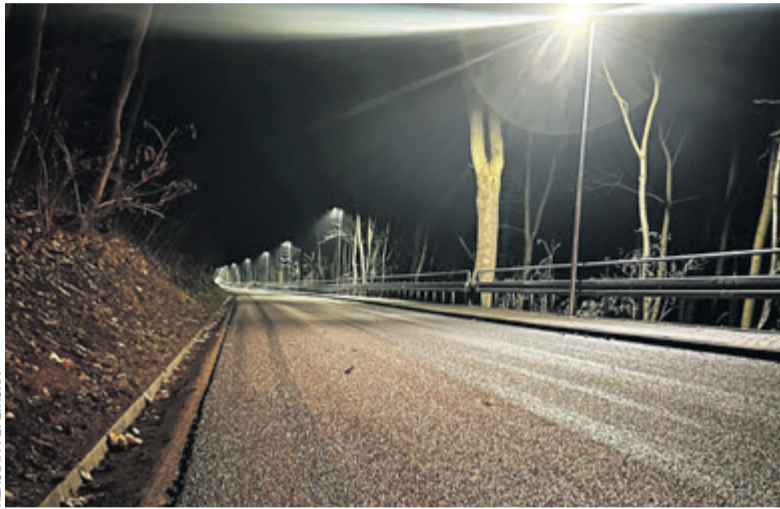
Droga prowadząca nad Jezioro Starogrodzkie – tzw. Hajratka – zyskała chodnik z oświetleniem i nową nawierzchnię
