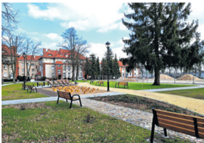
Na terenie byłej jednostki wojskowej powstaje Chelmska Dzielnica Społeczna. Zakończył się już I etap prac, który objął m.in. budowę dróg, chodników, realizację wodociągu oraz kanalizacji sanitarnej i deszczowej
