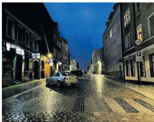
Historyczną nawierzchnię kamienną odzyskała ul. Wodna. Prace poprzedziła wymiana infrastruktury podziemnej, w tym wodociągu
