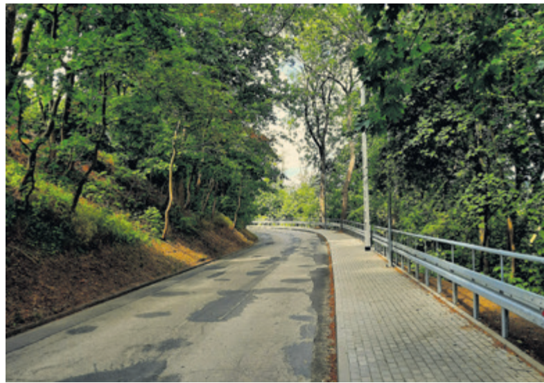
Hajratka zyskała chodnik z oświetleniem, trwają prace przy nowej nawierzchni
