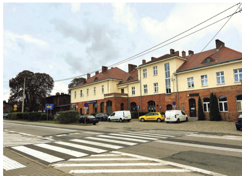
Miejsce inwestycji przy ul. Dworcowej
