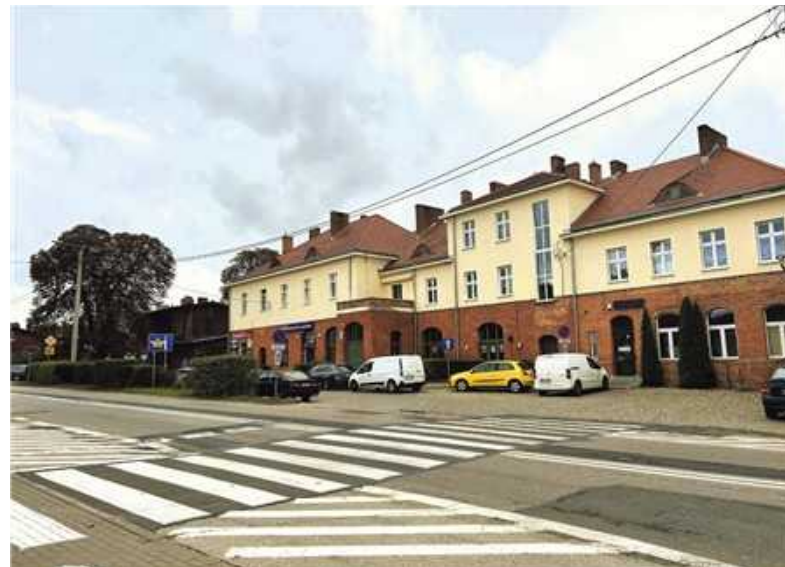
Miejsce inwestycji przy ul. Dworcowej
