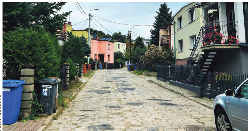
Ulica Brzozowa zyska nową nawierzchnię betonową
