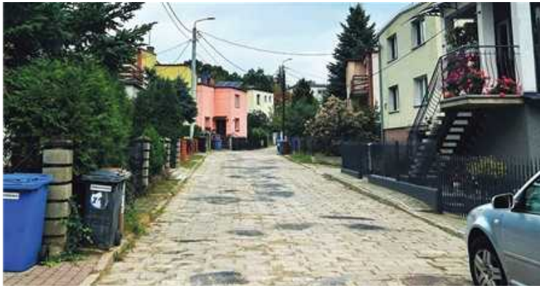
Ulica Brzozowa zyska nową nawierzchnię betonową
