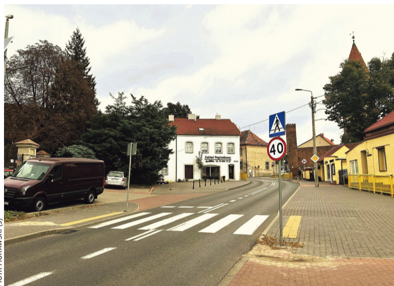
Wytypowane do prac przejście przy cmentarzu na ul. Toruńskiej
