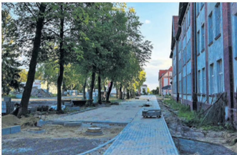
Rozpoczęte prace na terenie byłej jednostki wojskowej potrwają do końca roku
