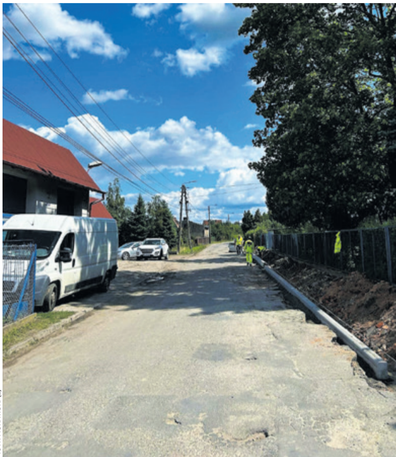
Prace na ul. Kilińskiego potrwać do końca października
