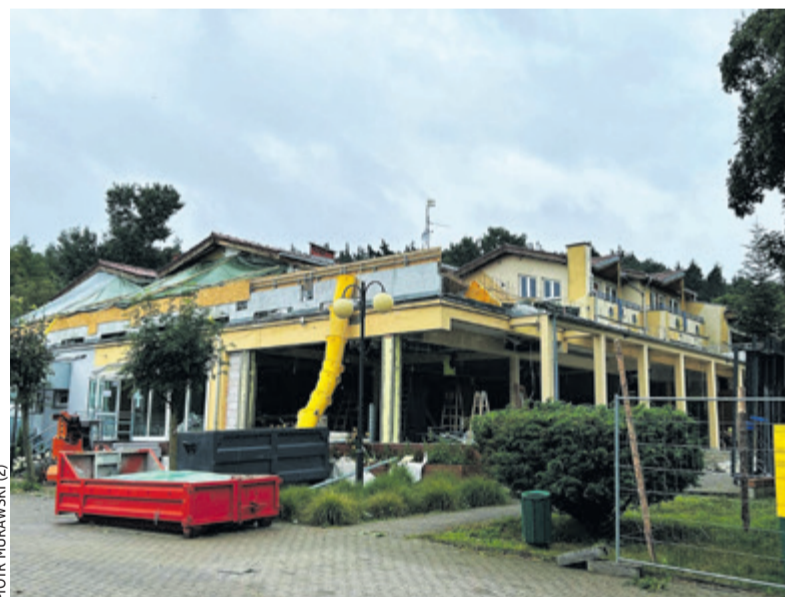
Remont obejmuje budynek hotelowy i restauracyjny
